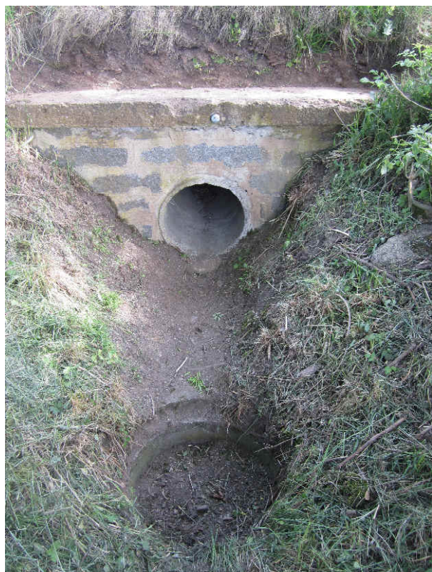
výtok trubního propustku DN 500 v km 5,417
