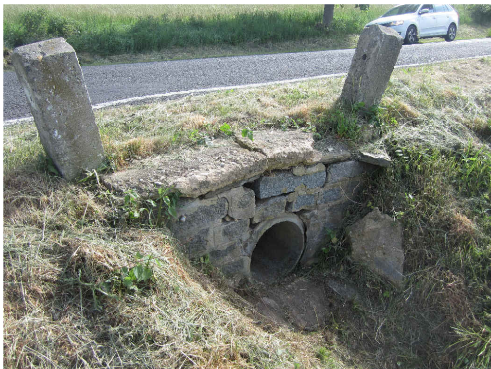
výtok trubiňho propustku DN 500 v km 5,312
