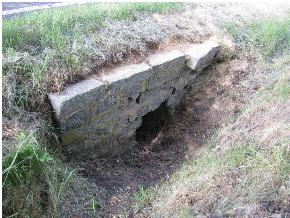
vtok trubního propustku DN 500 v km 5,417
