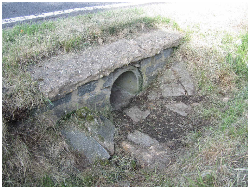
vtok trubiňho propustku DN 500 v km 5,312
