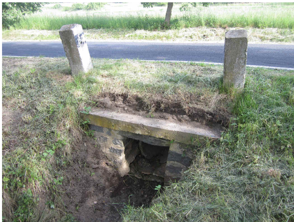
výtok trubního propustku DN 500 v km 5,765
