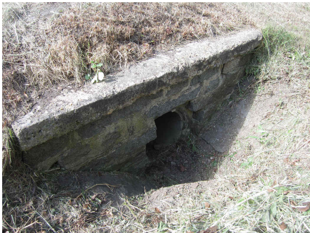
vtok trubního propustku DN 500 v km 5,765
