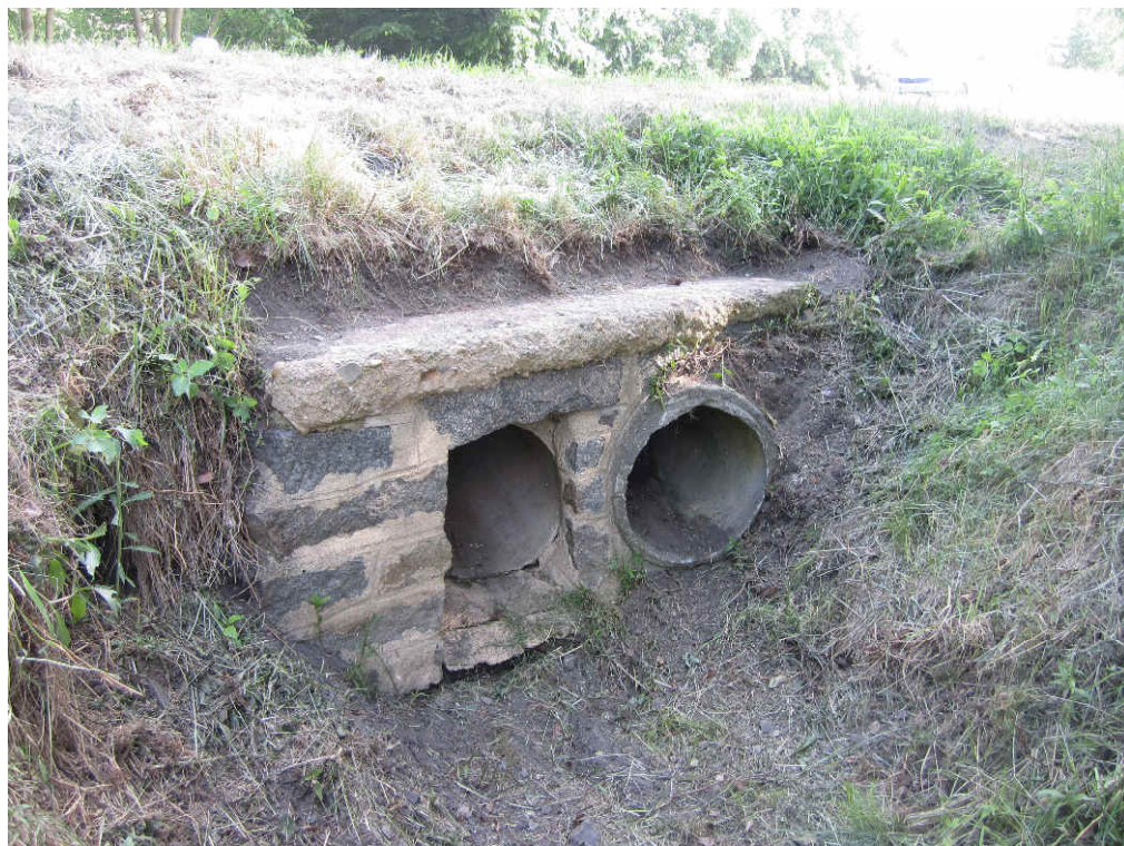
vtok trubního propustku 2x DN 400 v km 5,636
