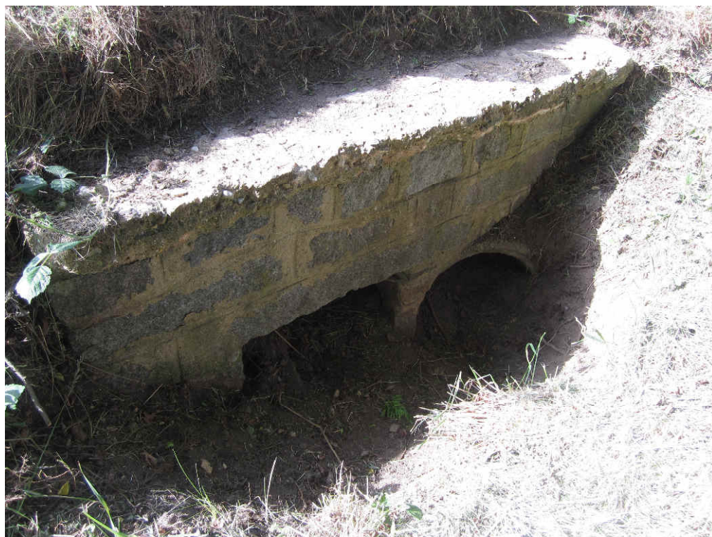
výtok trubního propustku 2x DN 400 v km 5,636
